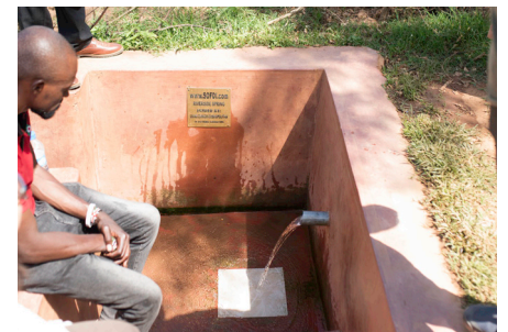
Beispiel einer gefassten und geschützten Quelle im Projektgebiet.
